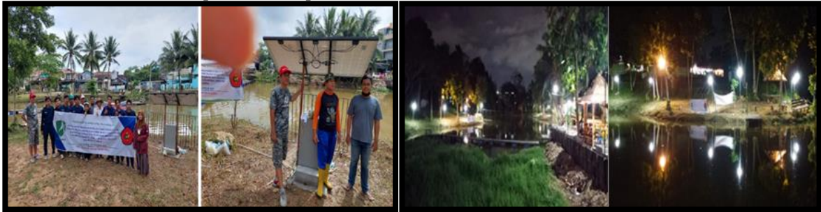
(a) Tim Pengabdian Masyarakat Jurusan Teknik Elektro dan (b) Hasil pemasangan Modul Surya sebagai sumber listrik
