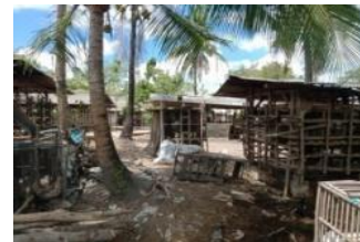
Gambar 6. Bangunan hunian yang tidak teratur, antar bangunan hunian sangat dekat dengan kandang
