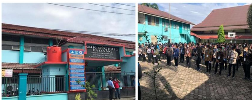
Gambar 1. Gedung Sekolah SMKN 2 Padang
