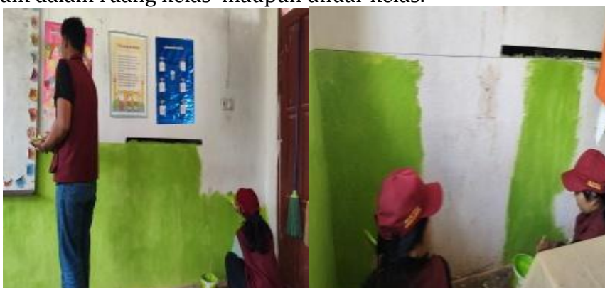
Gambar 8 Pengecatan Ruang kelas
