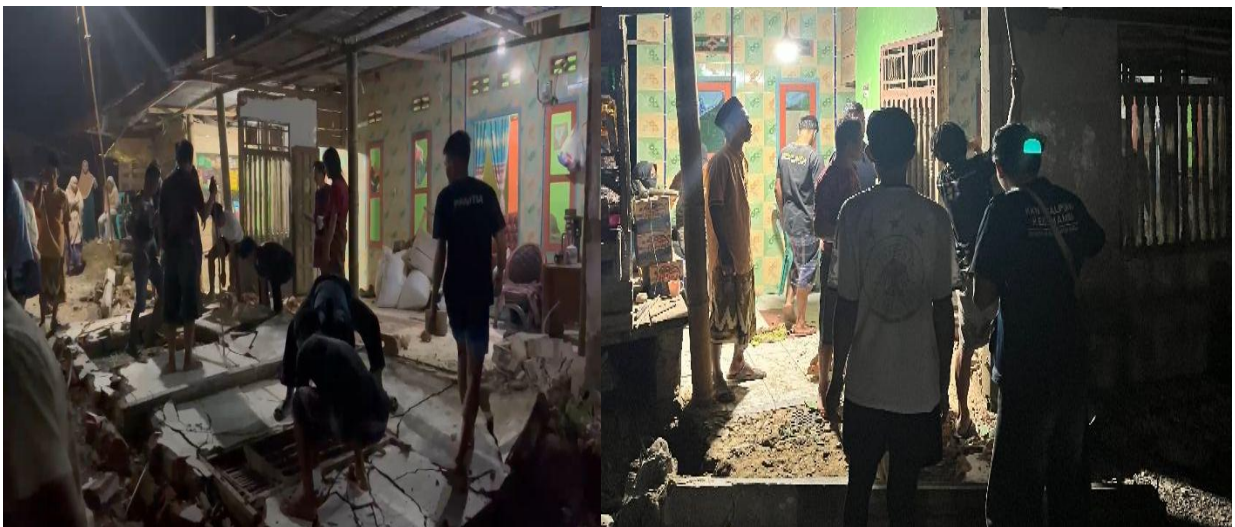
Gambar 16 Membantu warga merobohkan rumah untuk pelebaran jalan
